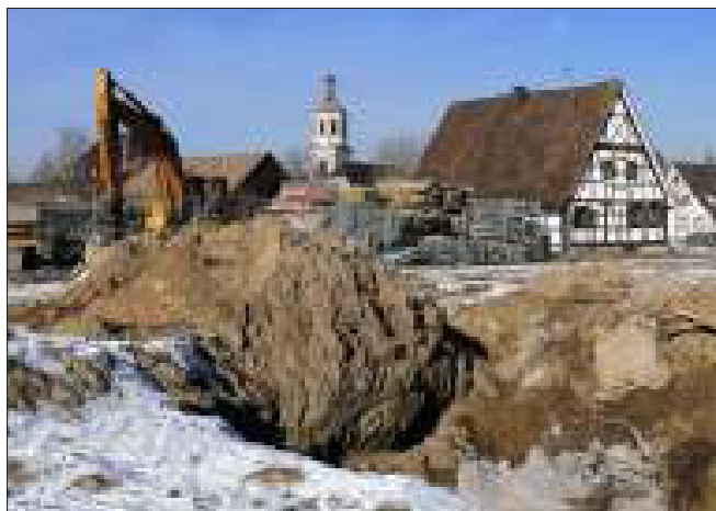
Umfangreiche Bauvorbereitungen wurden auf dem Gaus-Areal bereits getroffen.
