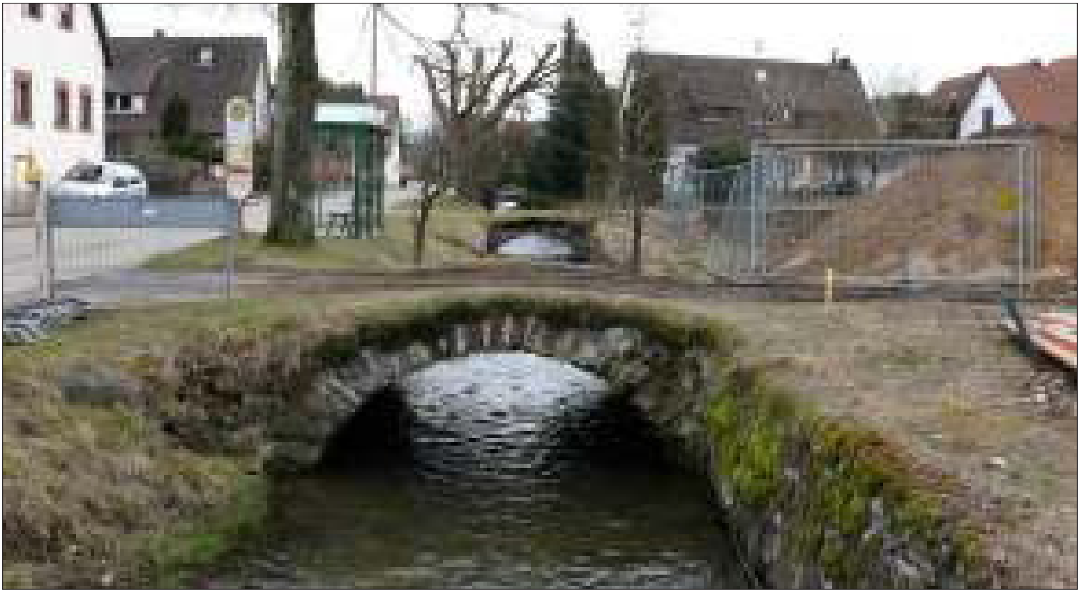
Eine neue Brücke nach alter Bogenbauweise wird hier entstehen; die hintere Brücke soll saniert werden.
