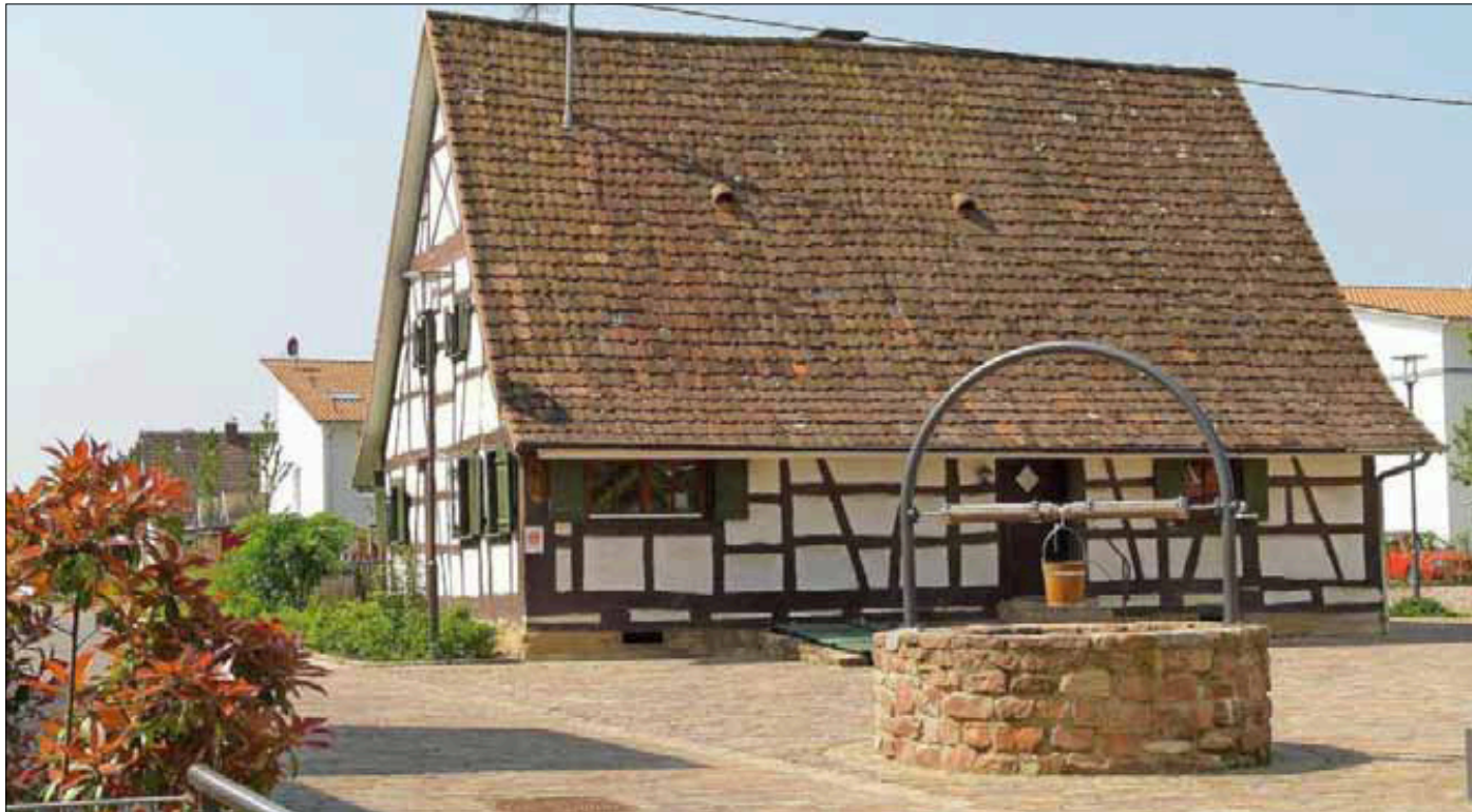
Das „Gaus-Haus“ beim Denzlinger Heimethues soll einer sinnvollen Nutzung zugeführt werden.
